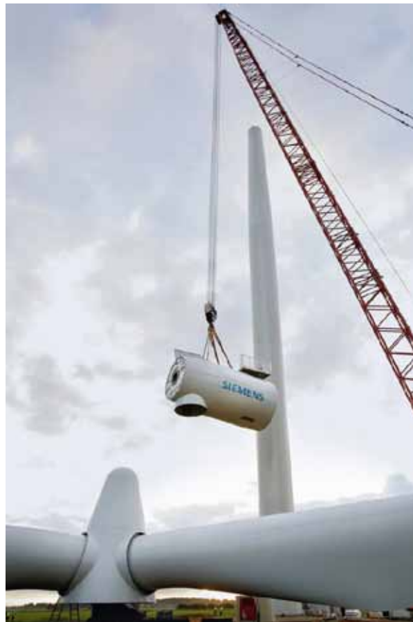
Bild 1: Einsatz eines Spezialkrans bei der Errichtung einer Windenergieanlage (Quelle: Siemens AG)
