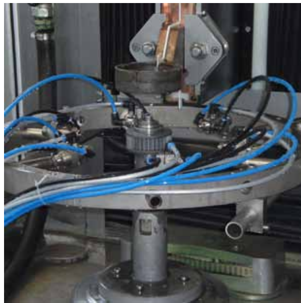
Bild 3: Sprayfeld in der Induktionserwärmungsanlage (Quelle: eldec, IW)
