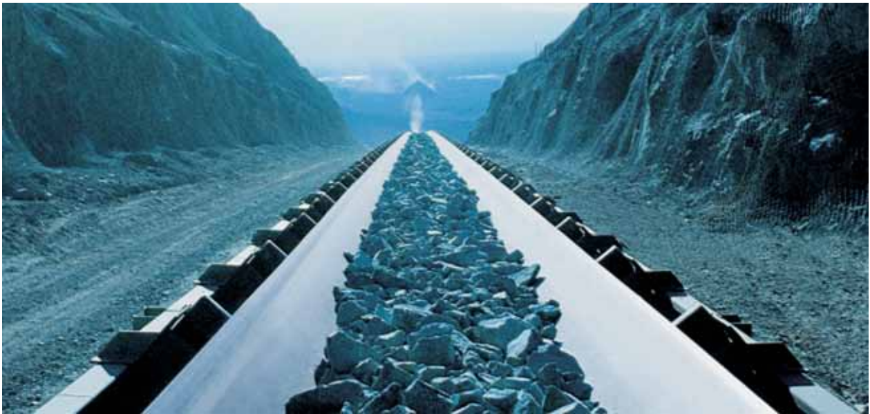
Bild 2: Steuerung durch Messung der Vorspannkraften an Gurtförderanlagen (Quelle: Phoenix Conveyor Belts)
