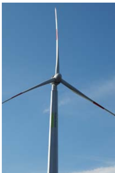
Bild 1: TimberTower im Einsatz (Quelle: TimberTower GmbH)
