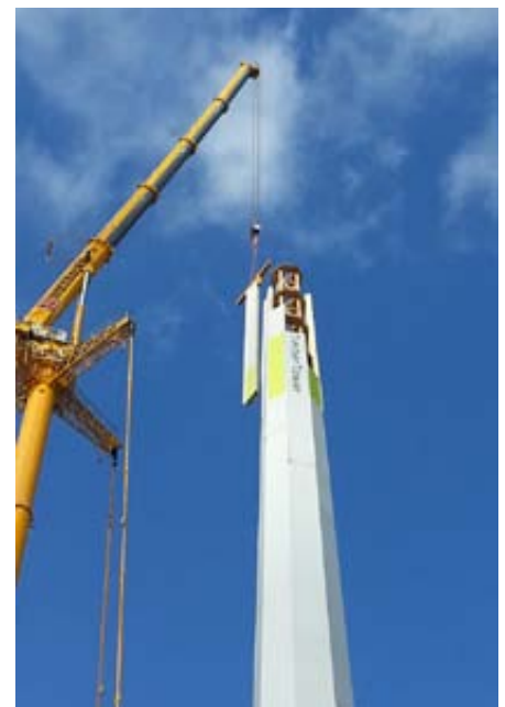
Bild 2: Montage der Module aus Holzplatten (Quelle: TimberTower GmbH)
