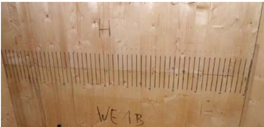
Bild 4: Massivholzelemente mit eingeklebten Lochblechen (Quelle: TimberTower GmbH)
